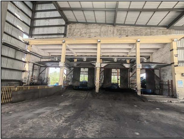
1号受煤坑集气装置
